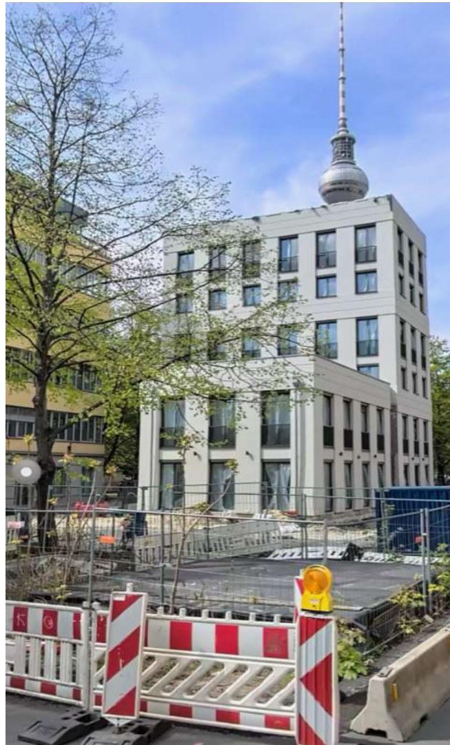
Baustelle EmMi LuebesKind-Haus Berlin-Mitte (November 2021)
